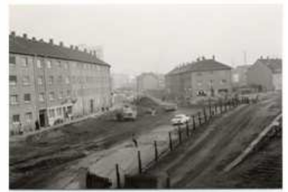
Großzügiger Umbau des Bereiches „Stich“, Blick nach Südost auf die Leinenstraße und die Spinnereistraße.
