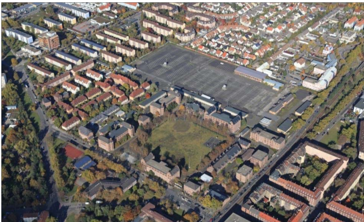
Abbildung 2: Luftbild (Schrägaufnahme aus südlicher Richtung)
